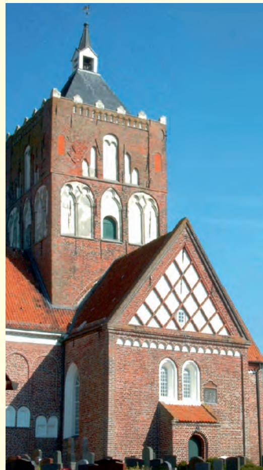
1 Pilsum, Ldkr. Aurich, Vierungsturm der Stephanus-Kirche mit den zugesetzten Öffnungen der Eckrisalite (hier rosa überhöht). Im Vordergrund das südliche Seitenschiff.
