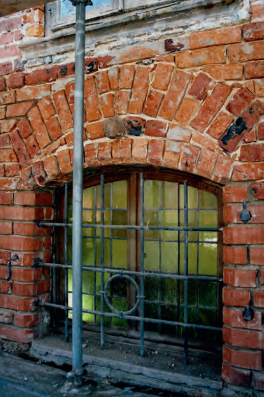
6 Celle, Altes Rathaus, wandbauzeitliche Kellerfensteröffnung im Sockelbereich der Ostfassade mit kantengefastem Backsteingewände und Entlastungsbogen.
