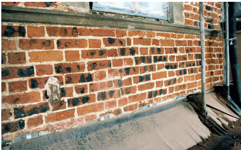
5. Zelle, Altes Rathaus, Backsteinmauerwerk in der obergeschossigen Brüstungszone der Nordflügelostfassade. Mauerwerk Bst 1, überwiegend im Wendischen Verband.
