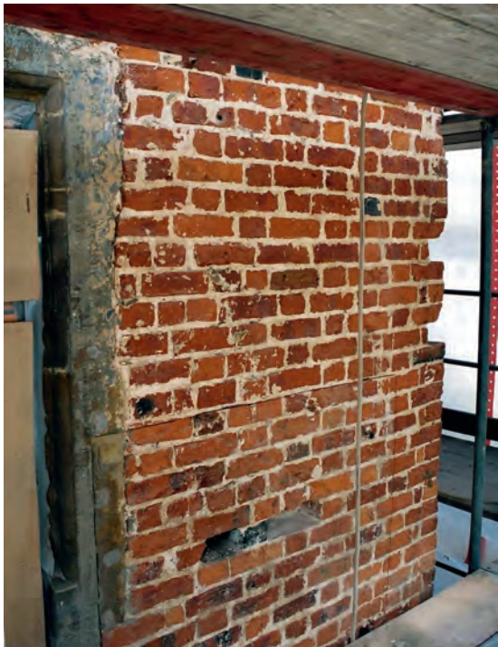
4. Zelle, Altes Rathaus, Backsteinmauerwerk am Nordende der Ostfassade. Ausschnitt Erdgeschoss mit dem Mauerwerk Bst 1 im Gotischen Verband.
