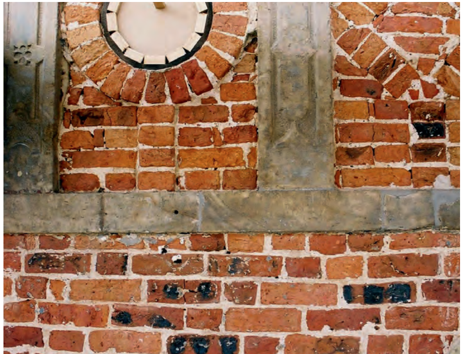
6 Celle, Altes Rathaus, wandbauzeitliche Kellerfensteröffnung im Sockelbereich der Ostfassade mit kantengefastem Backsteingewände und Entlastungsbogen.
