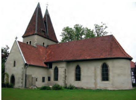
Lehre, Ev.-luth. Kirche. Vor der Instandsetzung mit dem baugeschädigten Zementputz.
