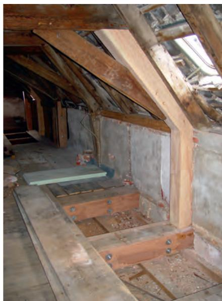
1 Auflagerpunkt der Deckenbalken mit dem Krümmer auf der Außenwand.
