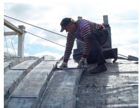
2, 3 Die Bleibahnen werden aufgelegt und auf der Unterkonstruktion befestigt.
