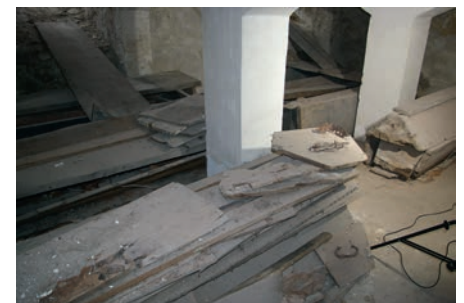
1 Blick in die Gruft bei Beginn der Arbeiten.
