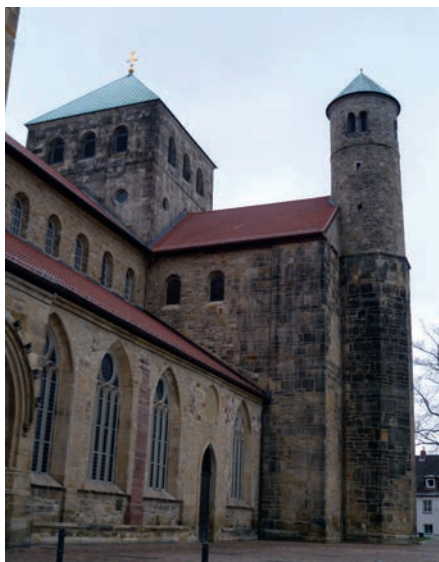
1 Hildesheim, St. Michael. Ansicht von Südwest.
