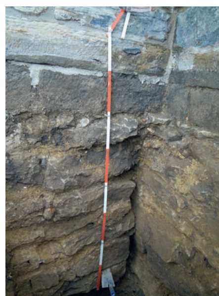
2 Hildesheim, St. Michael. Nördliches Seitenschiff, Fundament Ostquerhaus, vertikale Arbeitsfuge.
