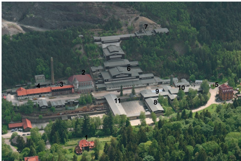
4 Goslar, Bergwerk Rammelsberg, mit Gebäuden sämtlicher Bauphasen: 1 Geschworenenhaus (17. Jahrhundert/1735), 2 Kraftzentrale (1906), 3 Kesselhaus (1909), 4 Werkstattgebäude, 5 Verwaltung/Kantine (1901), 6 Erzaufbereitung (1936), 7 Fördergerüst (1938), 8 Verwaltungsbau (1938), 9 Halle (1938), 10 Waschkäue (1938), 11 Magazingebäude (1939–41).
