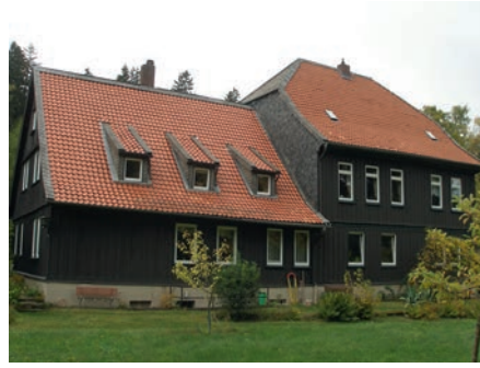
6 Ursprüngliches Geschworenenhaus (spätes 17. Jahrhundert/Erweiterung 1735).
