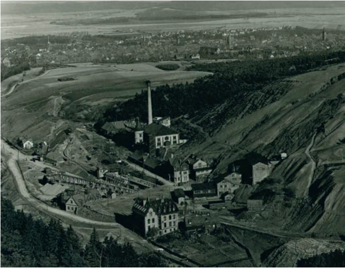
2 Goslar, Grube Rammelsberg, um 1915: mit Kraftzentrale (1906) und Schornstein des Kesselhauses (1909), davor Zechenhaus mit „Umkleidehalle“ (Waschkaue, 1910) Sieberei- und Klaubenanlage (1912, rechts) und dem Verwaltungsbau/Berginspektion (1901, vorne).
