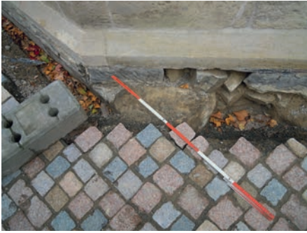
4 Hildesheim, St. Michael. Nordosttreppenturm.
