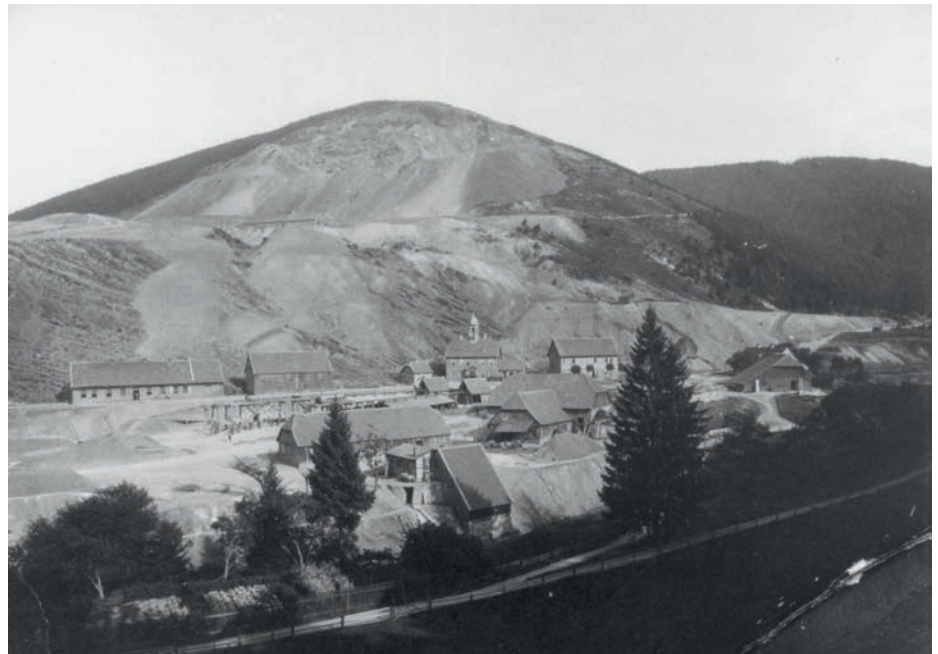
1 Goslar, Grube Rammelsberg, um 1900, mit dem Vorhaus am Mundloch der Tagesförderstrecke (1804, Bildmitte). Links daneben: Werkstattgebäude mit Schmiede und Materialschuppen. Rechts daneben: Zechenhaus von 1871. Im Vordergrund: Klaubenhaus und Erzwäsche. Dahinter die Sturzbühnen.
