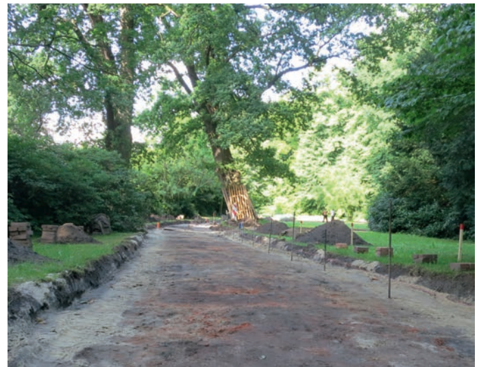
6 Auf der historischen Tragschicht wird die Wegedecke neu aufgebaut, 2014.
