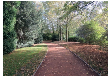
7 Parkweg auf ursprünglichem Niveau nach Wiedereinbau der überkommenen Randeinfassung und Ergänzung der erhaltenen historischen Tragschicht, 2014.
