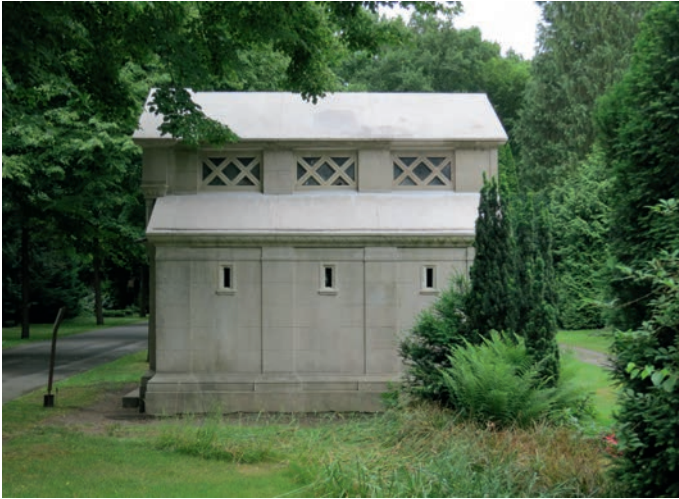
7 Hannover, Südstadt, Stadtfriedhof Engesohde, Mausoleum Völkers, Seitenfassade nach Nord-Westen, Zustand nach der Außensanierung.
