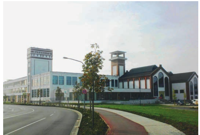
7 Spinnerei Busmaate nach der Umnutzung mit den 2011/14 angefügten Gebäudeteilen; 2014.
