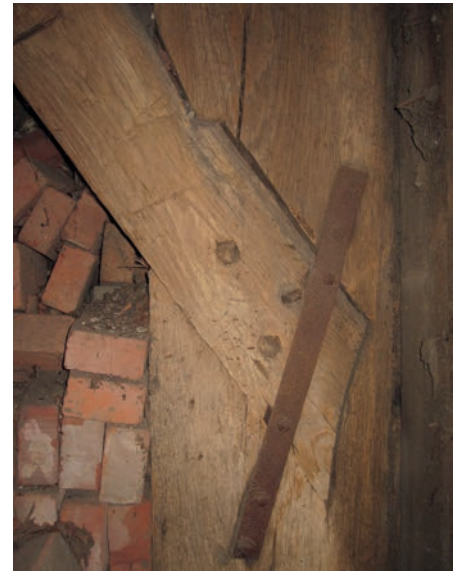
3 Anschluß einer Diagonalstrebe an den südöstlichen Eckständer: geschlossene Verblattung, ausgeführt als Hakenblatt mit schräger Brust und geschweifter Stirn.
