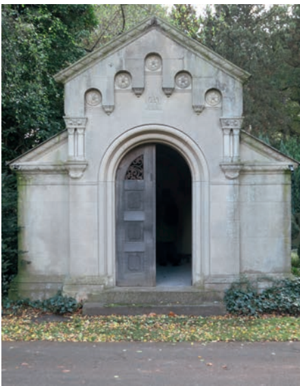
1 Hannover, Südstadt, Stadtfriedhof Engesohde, Mausoleum Völkers, Eingangsfassade nach Nord-Osten, Zustand vor der Sanierung.
