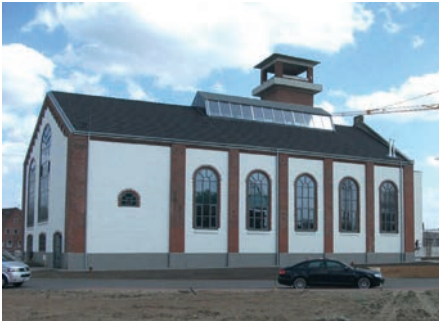
10 Ehemaliges Kesselhaus, rechts, mit angebauter früherer Schlosserwerkstatt, links, nach der Instandsetzung und Rekonstruktion der Fassaden; 2013.
