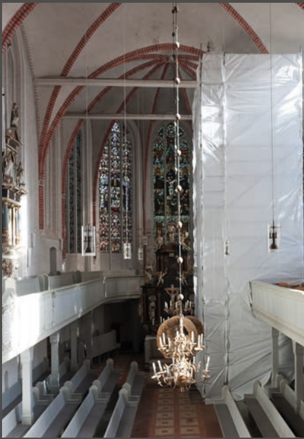
5 Kloster Ebstorf, Gerüstturm zur Voruntersuchung der Wandfassungen für die Sanierung 2015.
