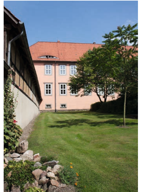
7 Kloster Isenhagen, Ansicht des westlichen Klosterflügels mit Sonnenschutzfolie im Bereich der Museumsräume im OG.
