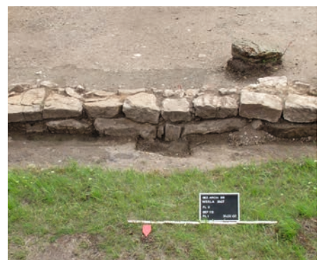
2 Pfalz Werla, Kapelle, Fundamentreste des nördlichen Querhauses während der Grabung 2007.
