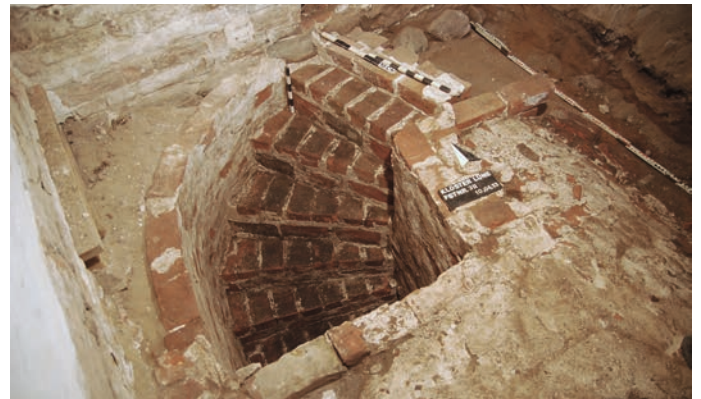
8 Kloster Lüne. Die Nordwand des Kapitelsaals im Querprofilschnitt. Fundament des Kreuzganges reicht nicht tief; unten der Rest eines Stampflehmbo- dens.
