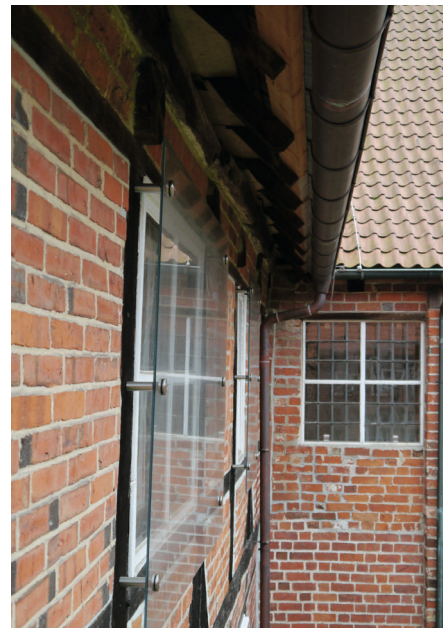
4 Kloster Wienhausen, Kapitelsaal, außen angebrachte Schutzverglasung.
