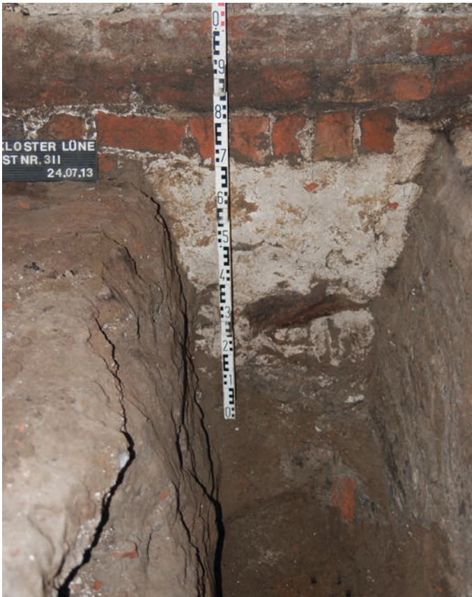
7 Kloster Lüne. Die Südwand des Kapitelsaals im Querprofilschnitt. Fußbodenansatz unten an der Meßlatte.
