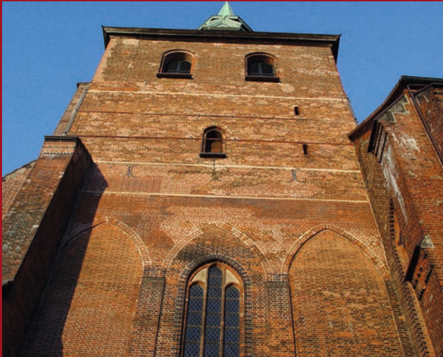
1 Lüneburg, St. Michaelis. Südfassade des Turms nach der Instandsetzung 2008 mit partieller Verwendung des Gips-Kalk-Mörtels V5 zum Mauern und Verfugen.
