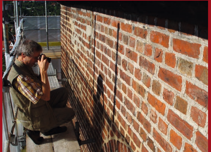
2 Lüneburg, St. Michaelis. Historischer Befund an der Ostfassade des Turms in ca. 40 m Höhe. Gute Erhaltung des Gipsmörtel-Mauerwerks im wettergeschützten Bereich.
