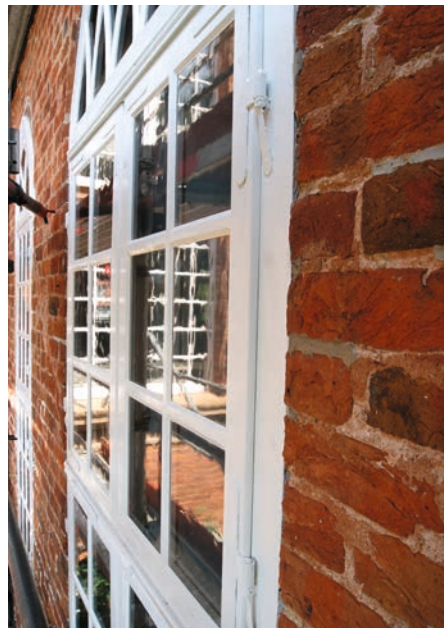
3 Kloster Walsrode, Fenster in der Westfassade der Kapelle. Ansicht von außen nach Fertigstellung der Restaurierung und Anbringung der Sonnenschutzfolie.
