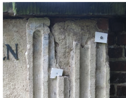
5 Klosterfriedhof Marienwerder, Grabmal von Wehrs, provisorische Fixierung abgenommener und gereinigter Stuckpartien.
