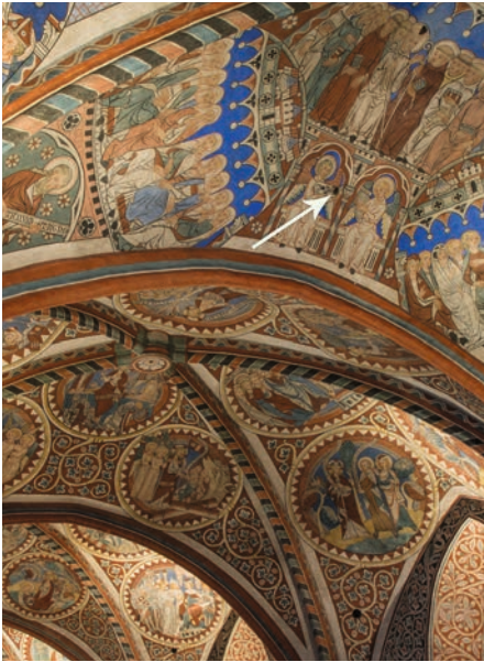
2 Kloster Wienhausen, Gewölbe des Nonnenchors mit dezent verborgenem Rauchansaugsystem.
