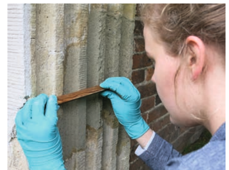
6 Klosterfriedhof Marienwerder, Grabmal von Wehrs, Ergänzung eines Pilasters durch Dorothee Schraeder, Praktikantin der Restaurierungswerkstatt der Klosterkammer Hannover.
