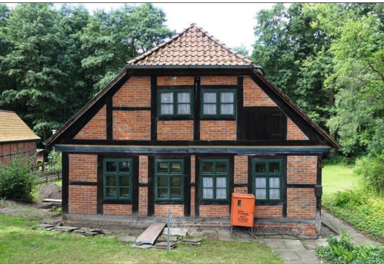
1 Kloster Isenhagen, Gärtnerhaus, Ostfassade 2016 vor der Sanierung.
